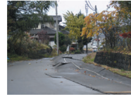
亀裂が入り、大きく隆起した道路(長岡市)
