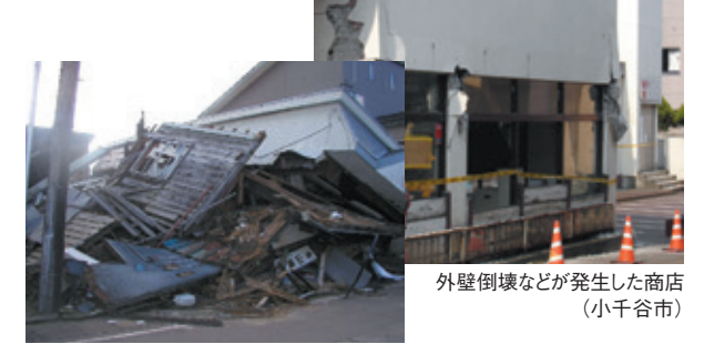
倒壊した木造家屋(川口町)
