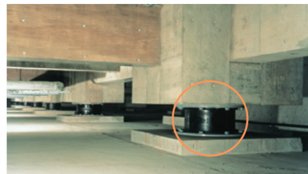
建物下に設置された免震装置(写真○部分)。免震建物は、揺れの強さを示す加速度が1/3~1/5になるため、震度が1~2小さくなります。
