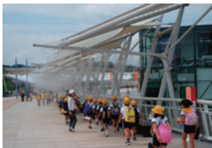
愛・地球博で日よけテントに設置された「ドライミスト」
