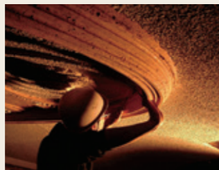
日本工業倶楽部会館での漆喰天井の再現作業
