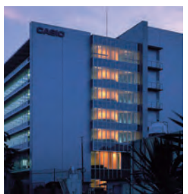
建物の内外から視認できる位置に堅型蓄熱槽を設置し、省エネのシンボルとしています(写真中央の黄色い筒が蓄熱槽)
