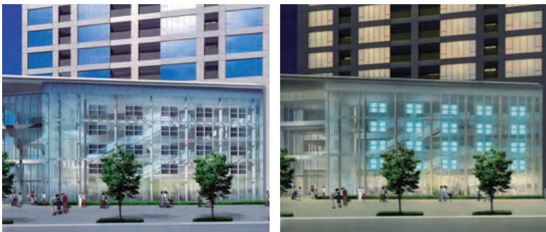
アルフレンテの外壁部には80枚の光る太陽電池を設置。発電分はCO2を発生しないので地球環境保全にも寄与します。光る太陽電池を本格的に建物の照明装置として使用したのは国内外でアルフレンテが初めてです
