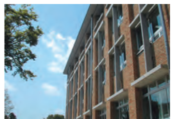
せっ器質タイルの外壁
