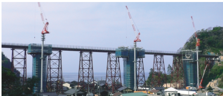
完成後には橋長約310メートルのコンクリート橋に生まれ変わります
