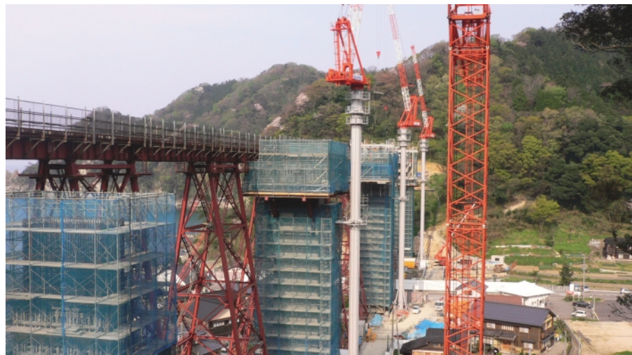
橋脚から左右に伸び始めた新たな橋桁。赤い鉄橋が現在の余部橋りょう
