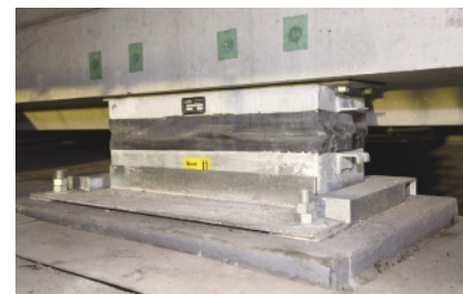
電車の振動と騒音を低減するフローティングスラブ防振軌道
