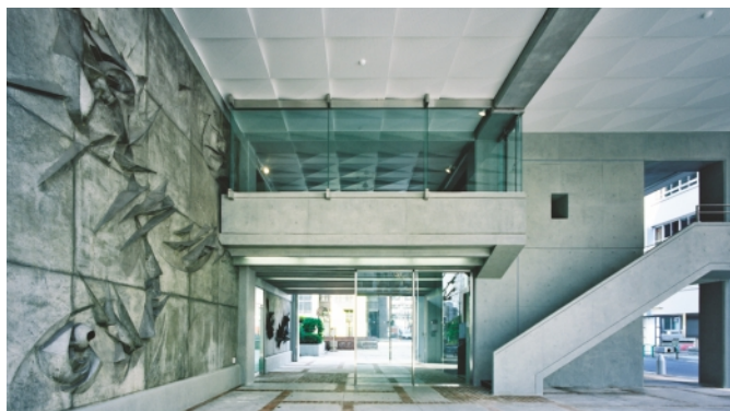
1階ピロティの2層吹き抜け壁に保存された小野襄のレリーフ（写真左側壁）
