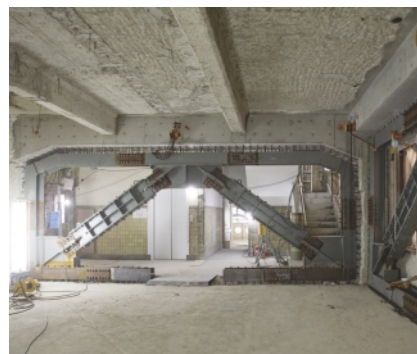
耐震ブレース。文化的価値を持つ外装材までも維持できる耐震性能を目標に補強を行いました
