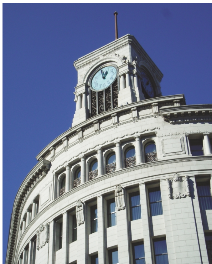
洗浄を行い、喪失した部分を可能な限り元に戻した外装
