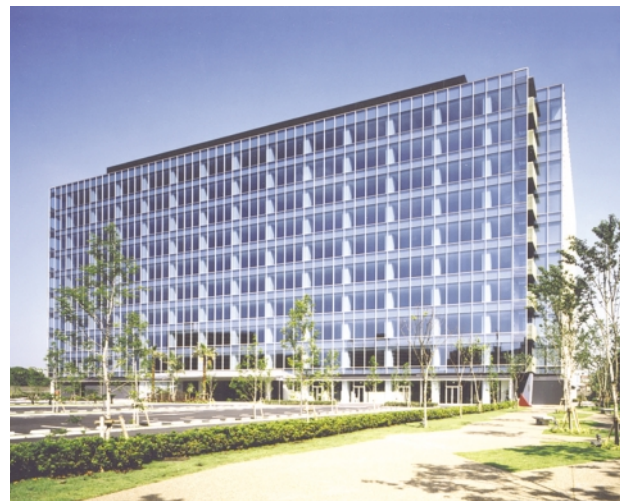
KDX豊洲グランスクエア。建物周囲に遊歩道を含む緑化スペースを十分に設け、敷地内緑化率は約25%
