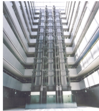
光と風の通り道となっているアトリウム
