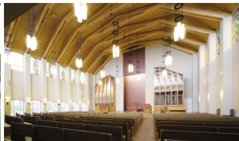
礼拝堂の屋根は、大断面集成材の梁で構成
