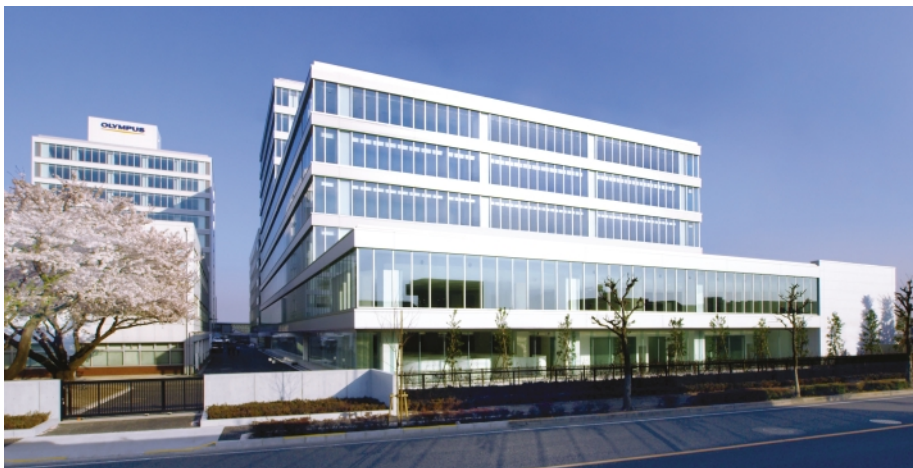
オリンパス技術開発センター石川新棟（右が開発棟、左が技術棟）。中央監視設備を導入し、エネルギーの使用状況をモニタリングしています
