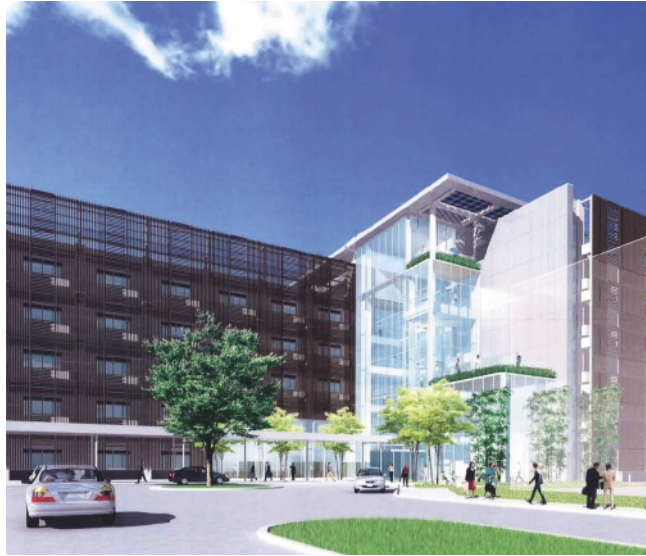
物質・材料研究機構 総合研究棟(茨城県つくば市)の完成予想パース (設計・パース提供:株式会社 梓設計) 規模:地上6階、構造:RC造(PCaPC造)・鉄骨造 建築面積:4,165.28m 2 、延床面積:14,776.72m 2
