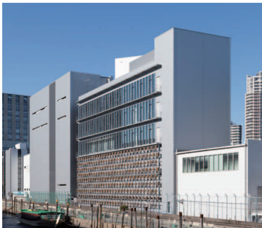
多目的実験棟
