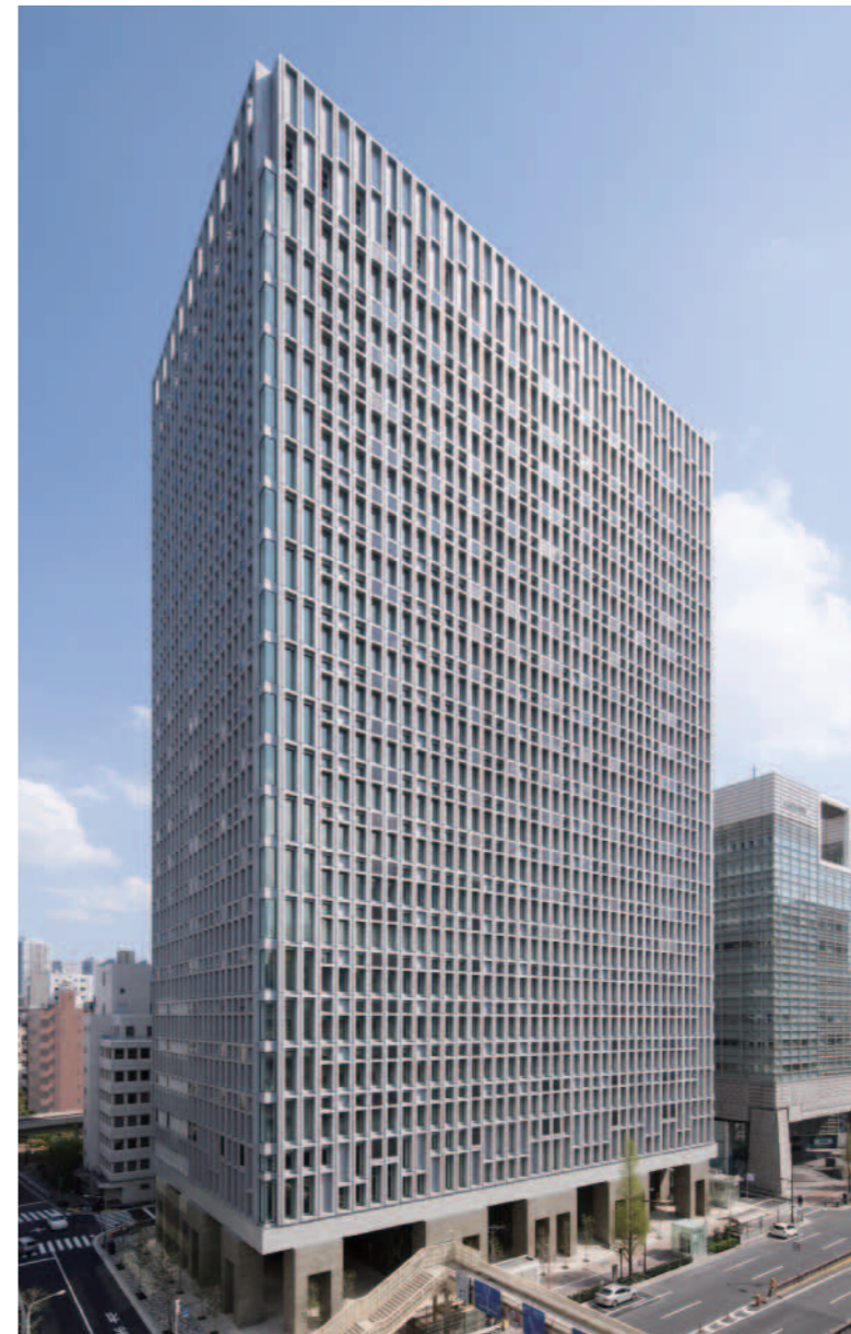
■建物概要 敷地面積：2,728m 2 建築面積：2,170m 2 延床面積：51,355m 2 階数：地下3階、地上22階、塔屋1階 建物高さ：106m 構造：鉄筋コンクリート造(一部鉄骨造) 免震構造
