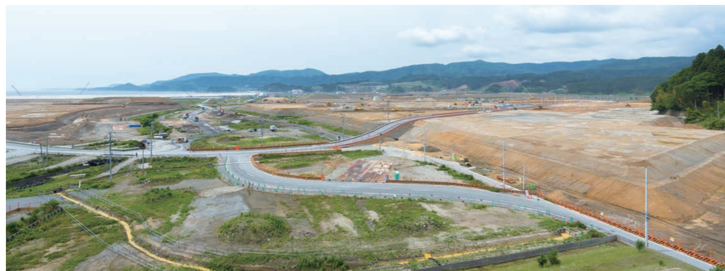
工事現場の様子
