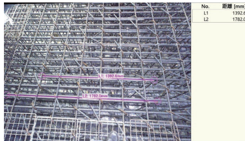
重ね継手長計測の表示例
