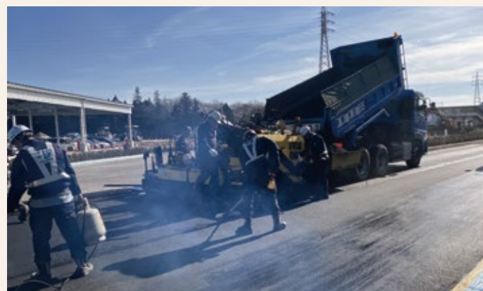
舗設時は、通常の機械編成で施工できます。
