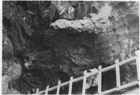
写真—11 薄い円筒状の壁を見下ろす
