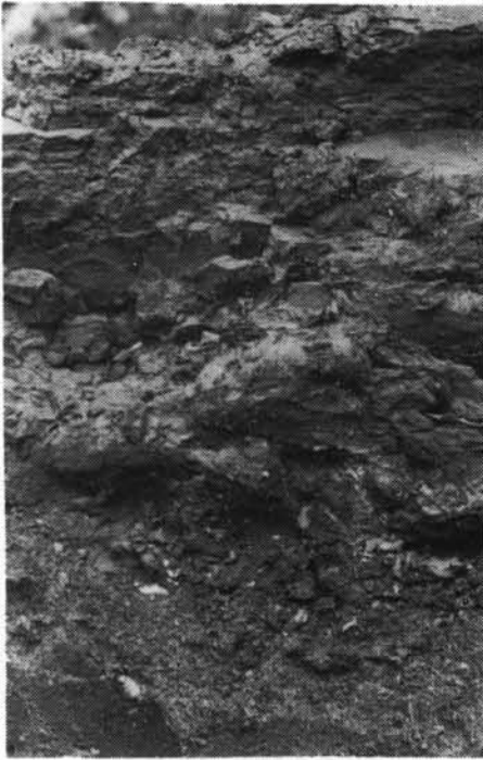
写真—10 砂層が薬液で完全に固結されている
