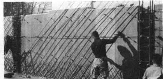
写真-6 配筋作業
