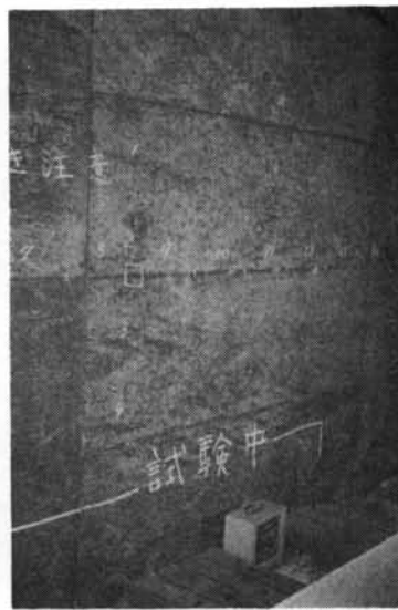
写真-10 現場内自由収縮試験体と壁面のコンタクトゲージ測定点
