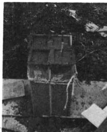
写真-13 自由収縮試験体(垂直方向打設)
