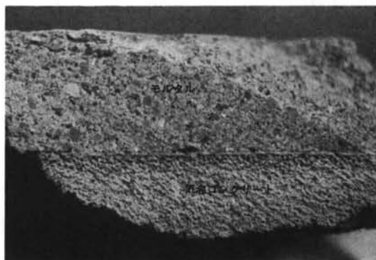
写真-5 特殊処理による硬質層の状態
