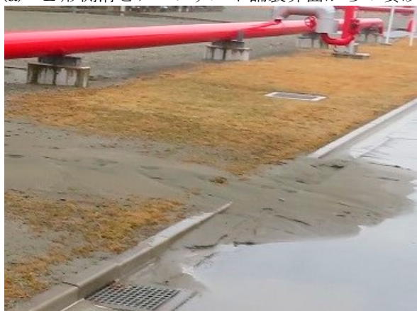
(b) L形側溝背面の芝生からの噴砂 写真-1 構内道路で生じた噴砂
