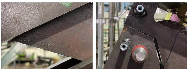
(左) 写真-2 鋼材ダンパーの黒皮の剥離 (右) 写真-3 金物 B と金物 W の接触(S2)
