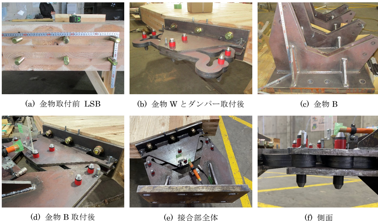
写真-1 鋼材ダンパー接合部の詳細
