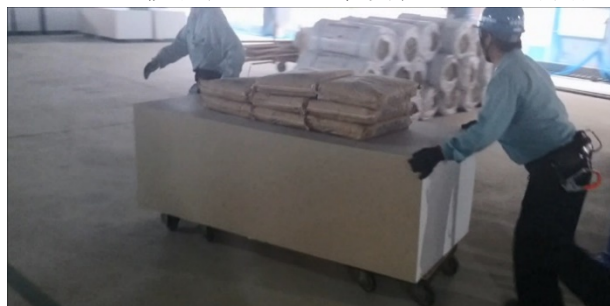
図-1 資材の手運搬
