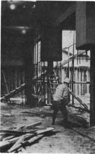
写真-1 逆打の現場状況
