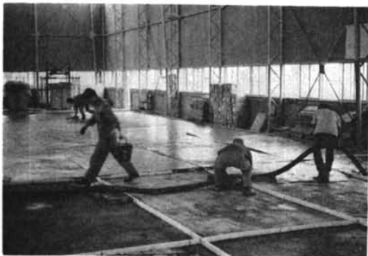
写真—1.A 実験の様子、気泡コンクリートの打込み
