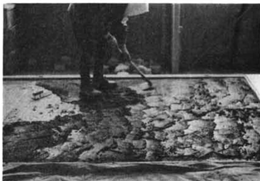
写真—1.B 混和剤 A M 混入モルタルのタッピング
