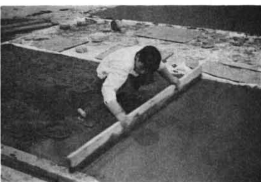
D モルタルの塗付け
