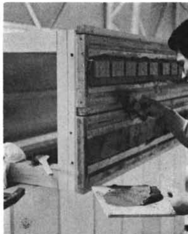
写真-2 張付けモルタルの塗付け
