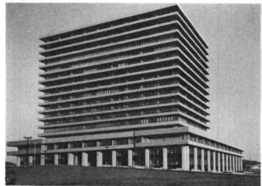
写真-1 第一生命大井町ビル
