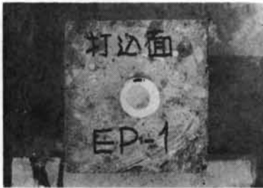
写真-4 EP-1の切断面
