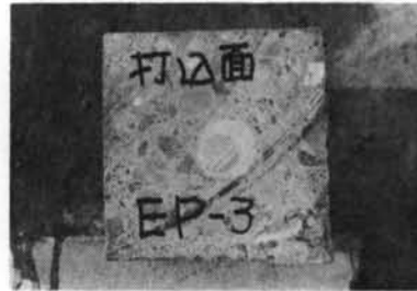
写真-6 EP-3の切断面
