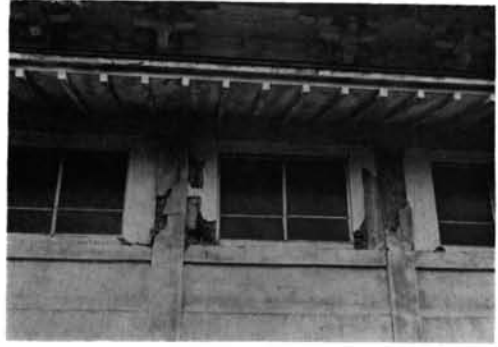
写真-2.37 来迎寺 コンクリートの質の悪さがうかがえる外柱の被害。 (以上来迎寺の写真は早大谷研究室提供)
