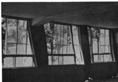
写真-2.86 函館大学 教室内部.
