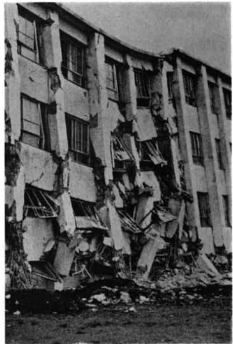
写真-2.79 函館大学 北側中央部の大きく崩壊した部 分。大きな柱と小さな柱が交互に配置されていることに 注意。1階の鉄筋が大きくはらんでいる。
