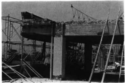
写真—2.69 むつ市役所 崩壊した3階の除去作業。
