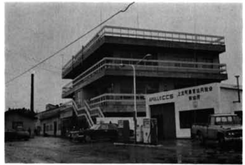
写真-2.57 上北町農協事務所 RC造3階の外観は極くありふれた建物で、柱スパンは直交2方向とも5.7mである。1階柱と1、2階壁にせん断破壊が生じた。
