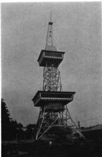
写真-2.32 八戸タワー 脚柱および頂部に近い部分で局部座屈を起こし傾斜した。
