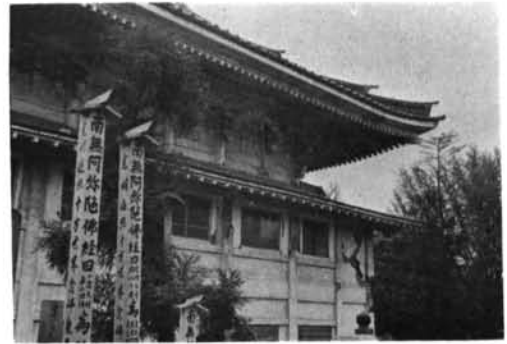
写真-2.34 来迎寺 SRC造で骨組は2層になっており、1階部分は半地下である。プランは図-2.5に示すように径515と650の円柱が主である。1層目はRC造であるが2層目は各円柱に鉄骨が入っている。あばら筋は設計ではスパイラルであるのに反し、実際は普通のあばら筋配置である。被害は2層目に生じていて、壁のない柱は柱頭柱脚で曲げ破壊、付随壁のあるものは曲げせん断またはせん断破壊を起こしている。
