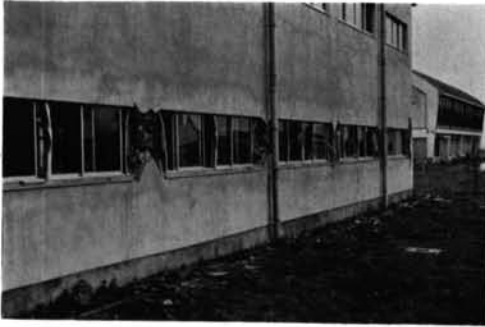
写真-2.14 八戸高専 南棟西寄部分を北側(廊下側)からみたところ. 腰壁と下り壁のためにせん断スパンが著しく短くなり, 水平力が集中してせん断破壊を招いた. 幸いにも校舎のこの部分は短辺に2スパンあるため他の2本の柱が鉛直荷重を支えている.
