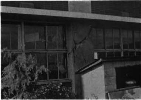
写真-2.48 三沢商高 既存棟の南側柱のせん断破壊 (1通り).
