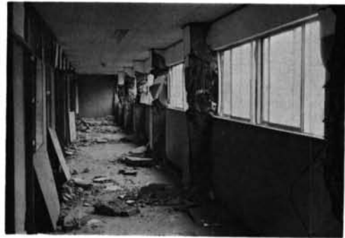
写真-2.18 八戸高専 南棟西寄部分の内部.
