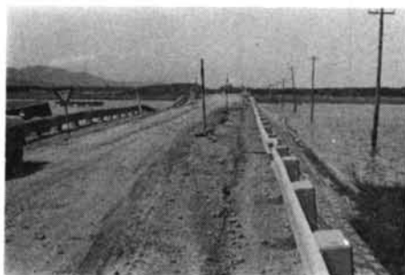
写真—3.26 鷹架橋端部取付道路の亀裂 （昭和43年7月4日撮影）
