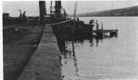
写真—3.39 むつ湾原子力船岸壁のせり出し（昭和43年7月4日撮影）
