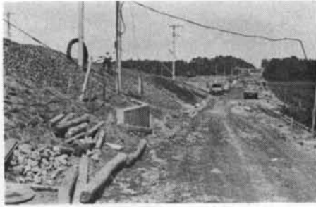
写真—3.35 東北本線小川原～上北町駅間の路盤沈下の復旧作業（昭和43年7月4日撮影）
