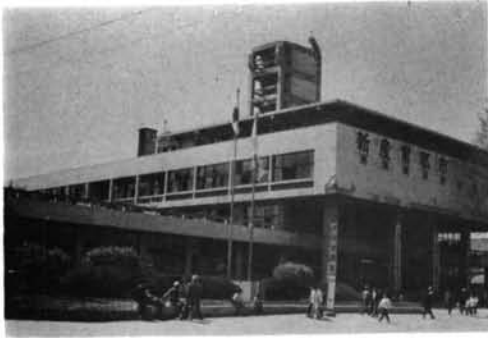
写真-2.31 八戸市役所 正面入口付近の被害(図-2.4 参照)
