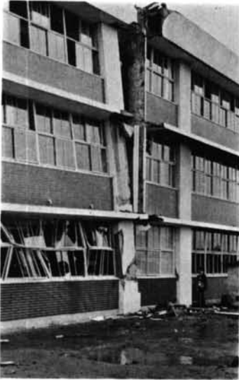
写真一2.43 三沢商高 エキスパンションジョイント付近.
