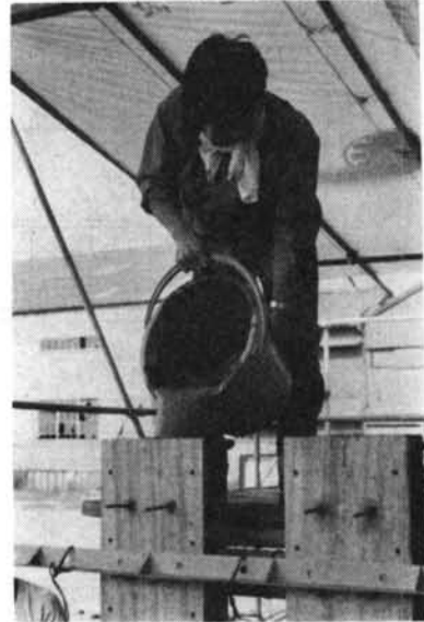
写真-2 先打ちプレパクト・モルタルの打設
