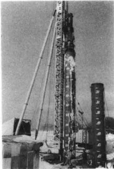
写真-1 くい打ち試験
