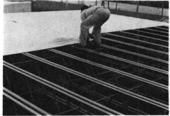
写真-1 JOIST 架構後キーストプレート敷設状況
