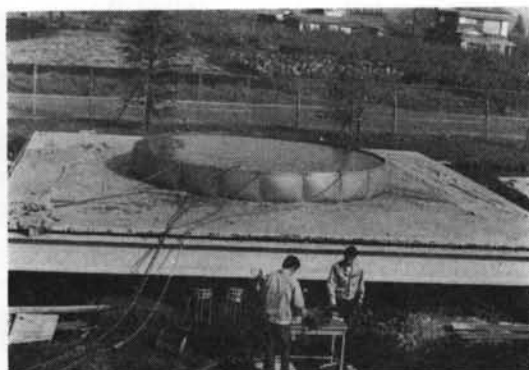
写真-2 JOIST 実大スラブ全景一満水の水そう
