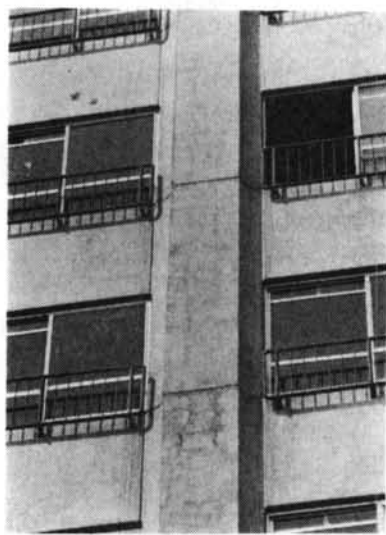
写真一二十一 外側はPC柱型
