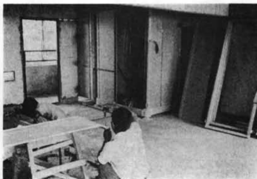
写真一七 ユニットバスの組立て
