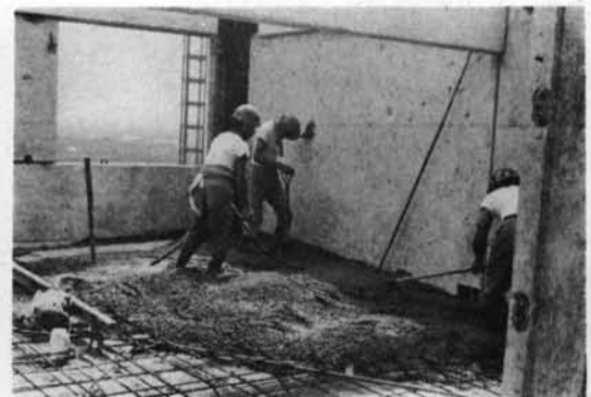
写真一二 床版は現場打ち 1ブロックずつ打設
