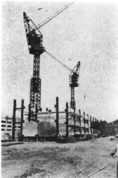
写真-5 タワークレーン
