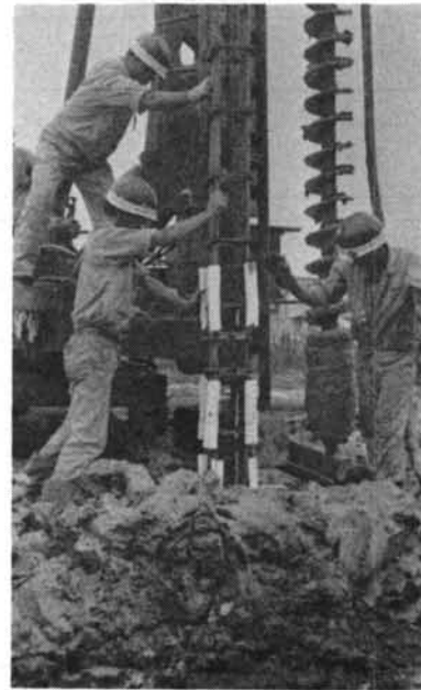
写真—1 Stテスト用PIPくい鉄筋挿入
