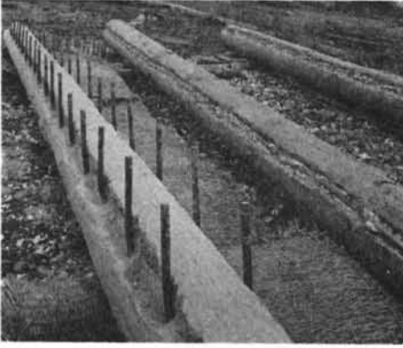
写真一2 打ち継ぎ面の表面処理状況とジベル鉄筋 (Gp300 シリーズ) P_z=0.63\%
