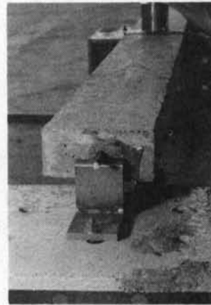
写真-4.1 はりの支持 (1点支持側)
