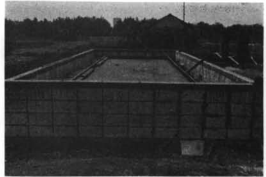
写真一 養生ピット
