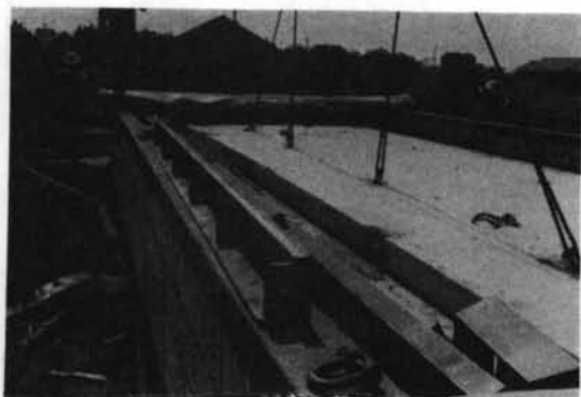
写真-13 建て起し最大吊り荷重5.0 t
