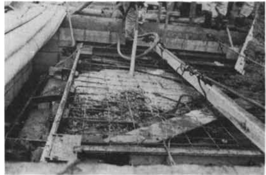
写真-5 コンクリート打設
