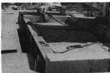
写真-1 PC版水平加力試験
