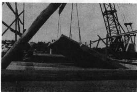
写真-14 吊り荷重3.5 t
