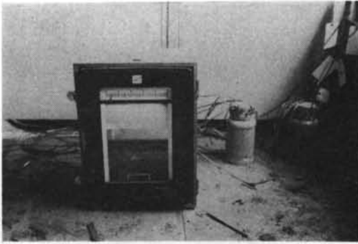
写真一六 電圧記録計
