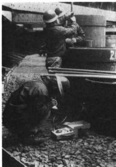
写真-2 Ⓑ・15 鋼管実測状況
