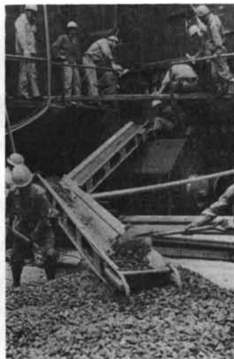
写真—13 ダクト工事
