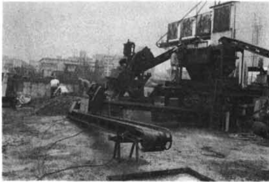
写真一八 粗骨材の混合装置
