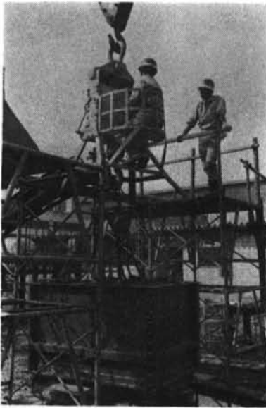
写真一2 実物大型わくの実積率測定 ×h30cmテストピースを採取して、比重の確認をも行なうことにした。
