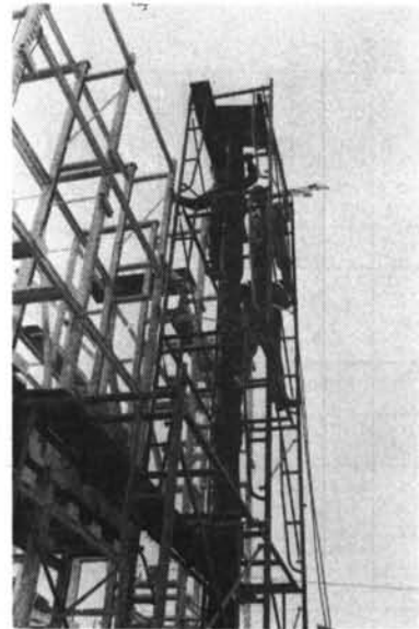
写真二〇 骨材落下試験
