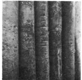
写真一10 A現場（その6）
