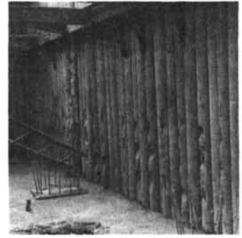
写真—31 E現場 (その3)
