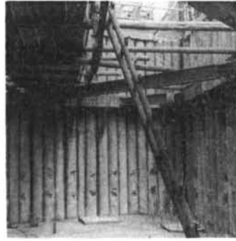
写真—30 E現場 (その2)
