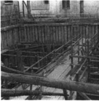
写真—29 E現場 (その1)
