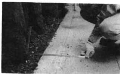
写真一 捨コン上の変位測定(A現場)
