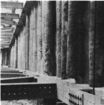
写真一8 A現場（その4）
