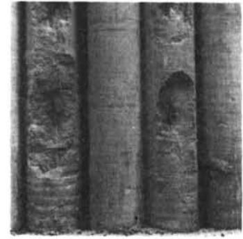
写真—34 E現場 (その6)
