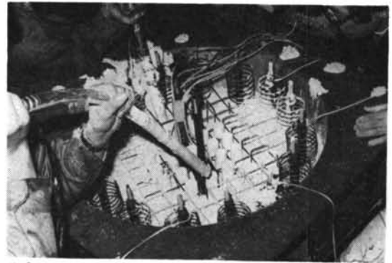
写真-3 コンクリート打設状況
