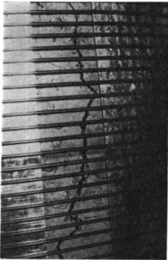
写真一五 マイクロコンクリート試験体の内圧 (80kg/cm 2 ) 時のきれつ状況
