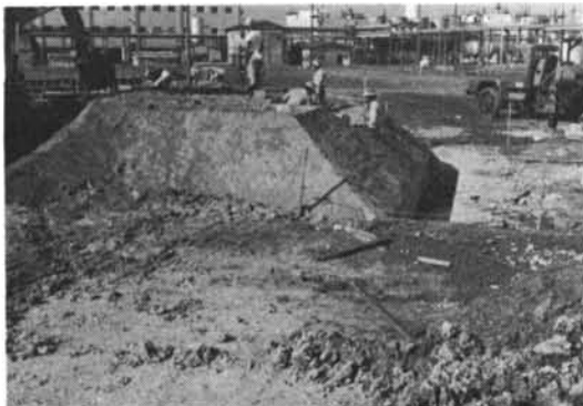
写真-1 実験溝に上載荷重として盛土（高さ（ h ）：1.5m、単位体積重量（ \gamma ）：1.58）を行なう。
