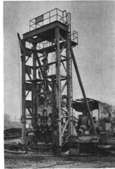
写真一1 清水式方向制御装置付き利根掘削機
