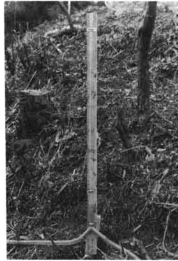
写真一1 水管式沈下計（直視）
