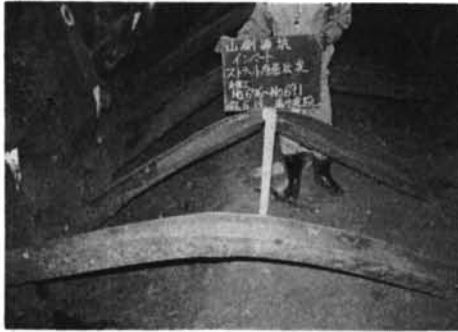
写真一1 インバートストラットの座屈変形状況 (山側導坑540m地点)
