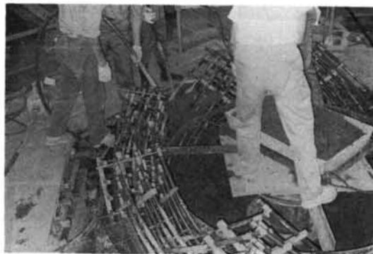
写真-4 下部スラブ建設状況
