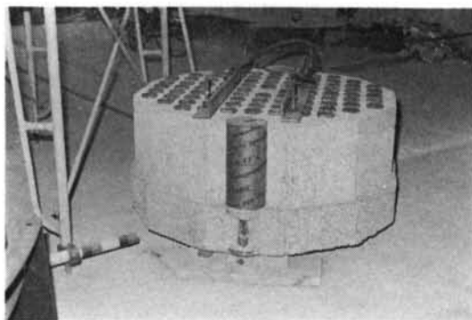
写真-3 トップスラブプレキャスト部
