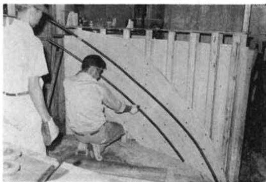
写真一五 ヘリカルダクトの加工
