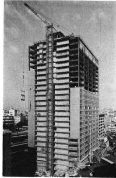
写真一1 施工中の第25森ビル
