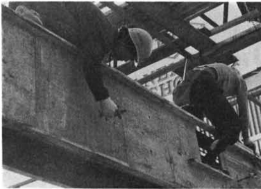
写真一 4 梁側せき板建込み
