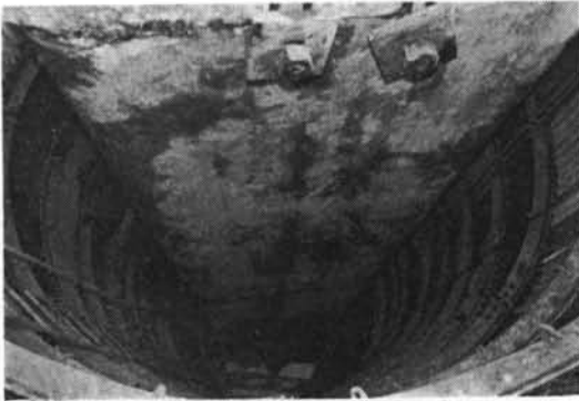
写真一五 SSSぐいの側壁面
