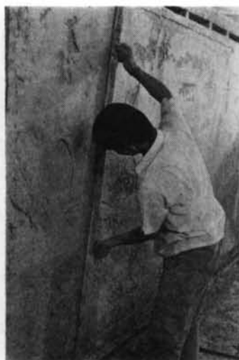
写真一3 作業性の検討 I. 定規摺り
