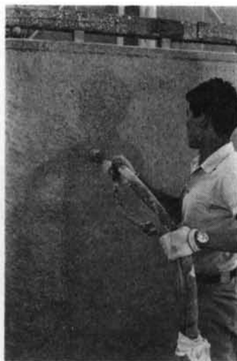
写真一2 吹付け作業実験
