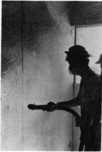
写真一7 現場施工実験 I. 吹付け作業
