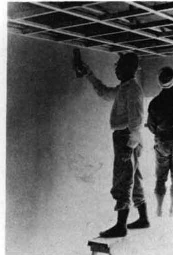
写真一9 現場施工実験 III. 金鏡仕上げ
