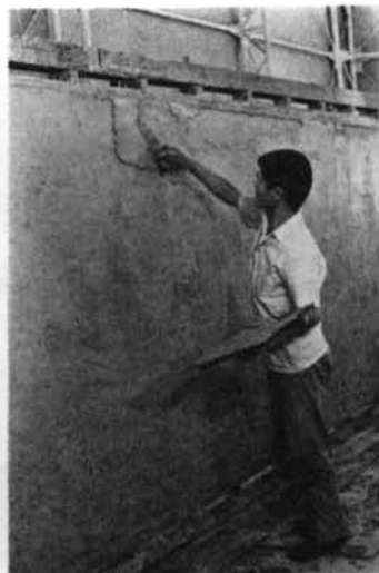
写真一4 作業性の検討 II. 鍔押え作業
