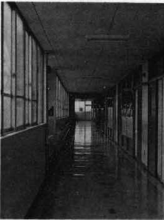
(b) 廊下(6通りから12通りへ、中央部が下がっている)
