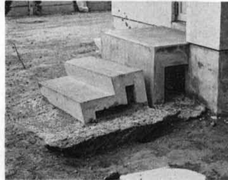
(b) 階段の状況
