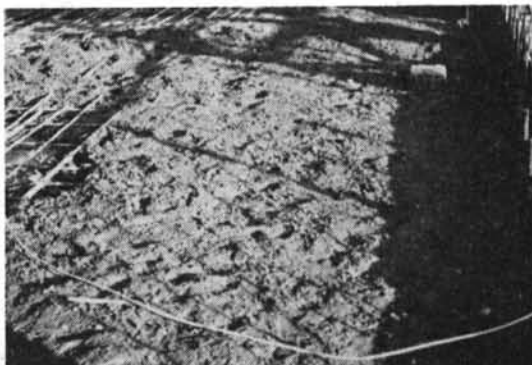
写真一5 外周壁の打設に伴うスラブコンクリートの処理 (SRC造)
