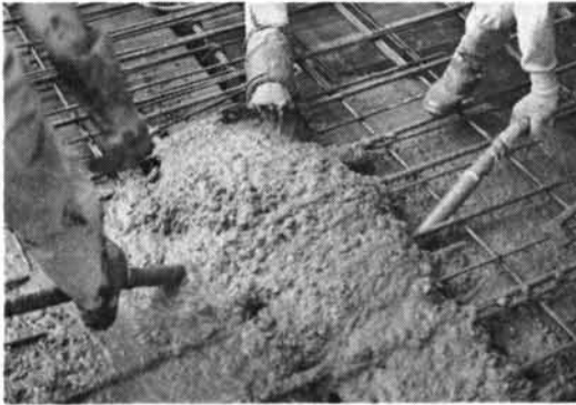
写真一三 内部の鉄骨を有する梁のコンクリート打設 (SRC造)
