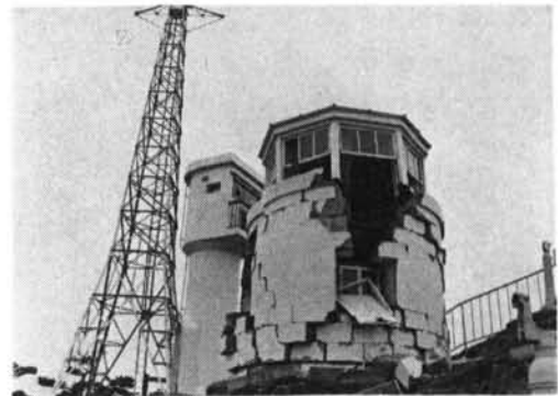
写真-8 石廊崎の旧海軍望楼(組積造)
