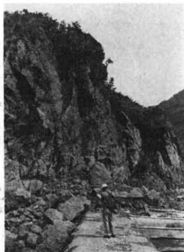
写真-3 入間海岸にみられたN30°E方向の亀裂にそった基岩崩壊
