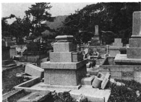
写真-2 入間地区の墓石はそのほとんどが転倒。残った墓石も南東方向へずれている。
