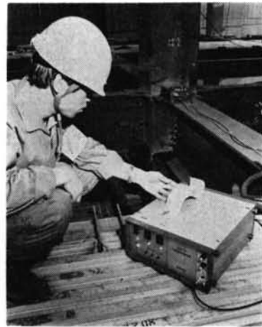
写真-7 現場の探傷状況
